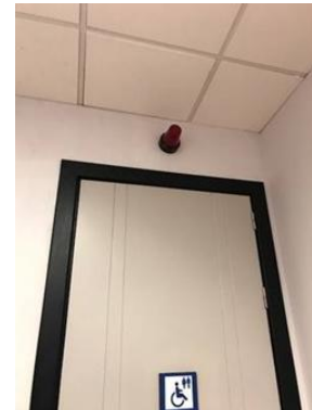
Señal lumínica y sonora situada en zona visible exterior y/o conectada a una zona de control o recepción.
