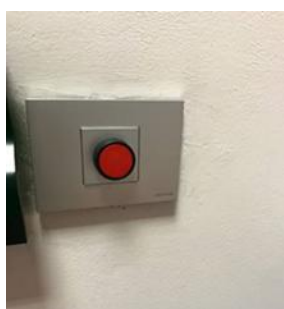
Pulsador: de corte de la señal situado en el exterior de la cabina.
